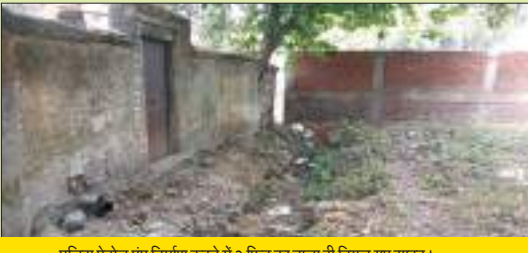
पुलिस पेट्रोल पंप निर्माण करने में 3 फीट का नाला ही निगल गए साहब।
